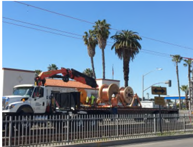
New OCS Wires
