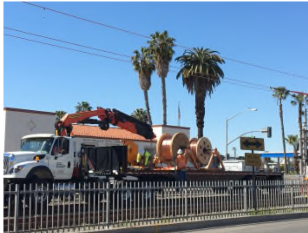
New OCS Wires
