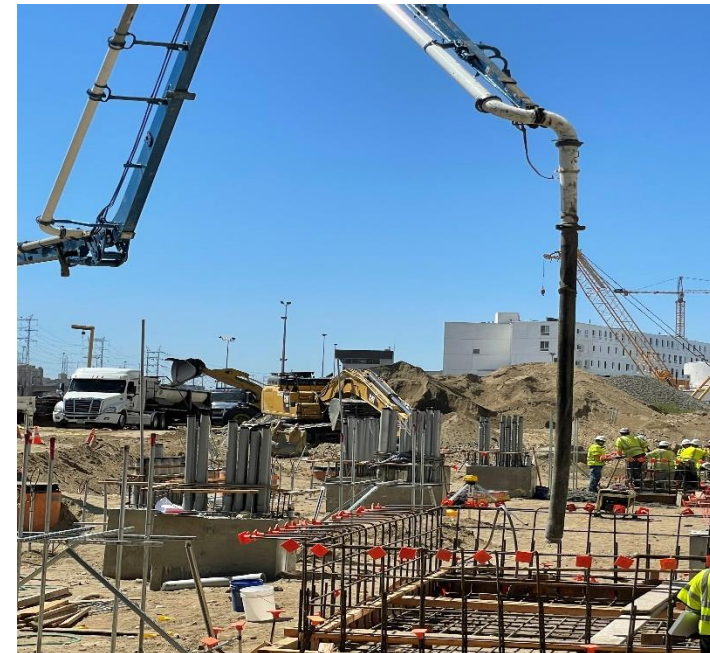
TPSS Pad Framework and Concrete Pour
