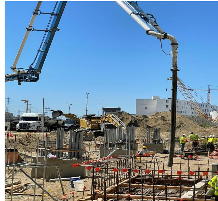
TPSS Pad Framework and Concrete Pour
