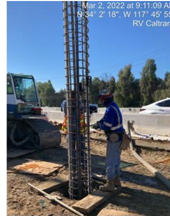
SW161 CIDH Pile
