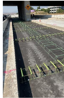
Preparation for SB JPCP Pour
