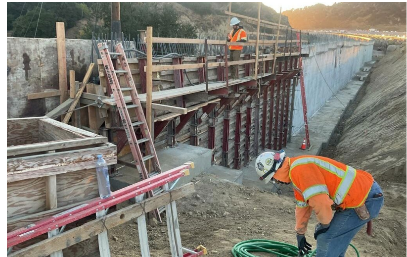
Retaining Wall 2460 Ready for Pour
