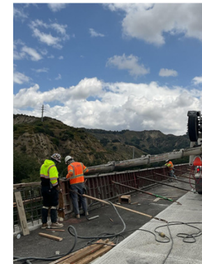
Concrete Barrier Pour at RW 2490
