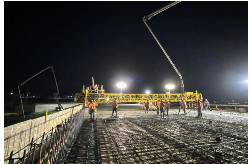
Deck Concrete Pour at Grand Avenue Bridge
