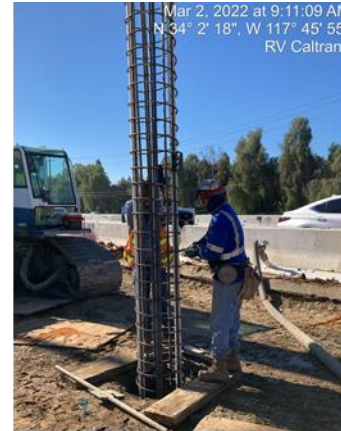
SW161 CIDH Pile
