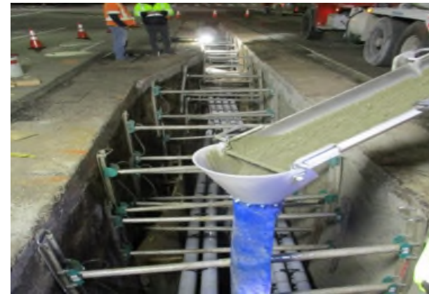
Conduit Encasing on Wilshire Blvd.
