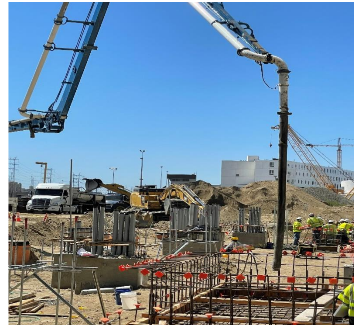
TPSS Pad Framework and Concrete Pour
